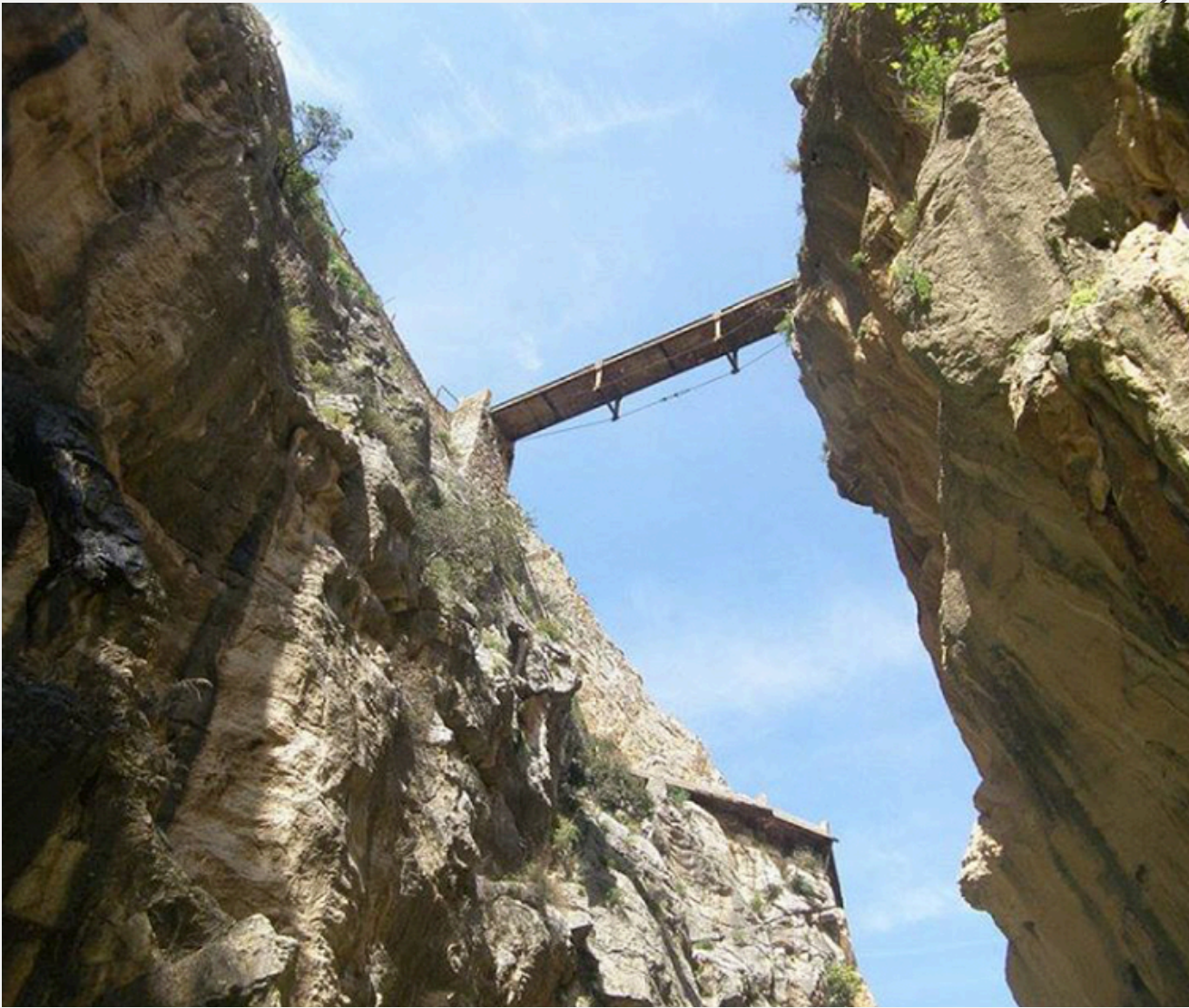
VISTA DEL PUENTECITO DEL REY DESDE ABAJO EN EL RIO
